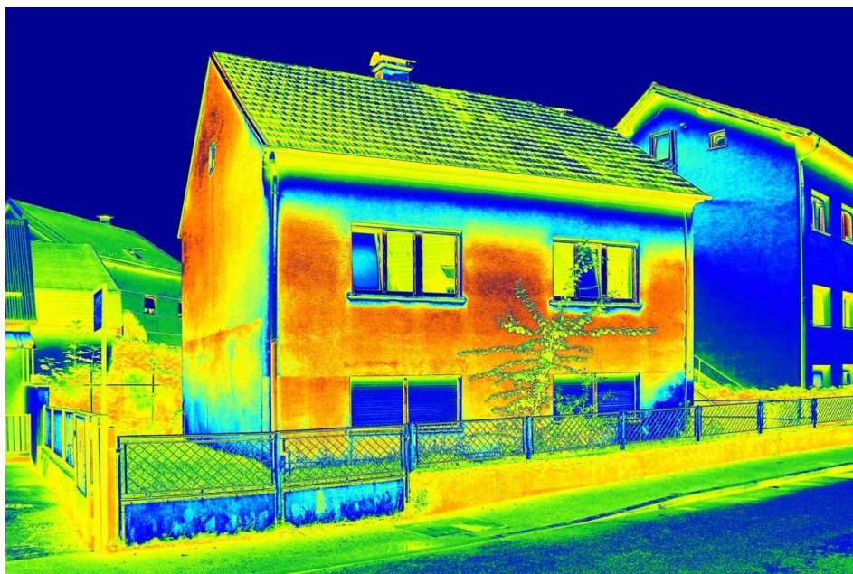
Termografibilleder af og i dit hus kan være en god vejledning.
